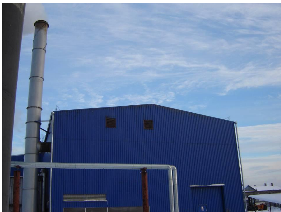
Рис. А.4-4. Введенная в эксплуатацию новая котельная на биотопливе
