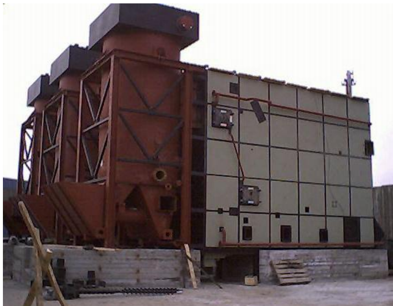
Рис. А.4-3. Котлы URBAS на этапе монтажа котельной
