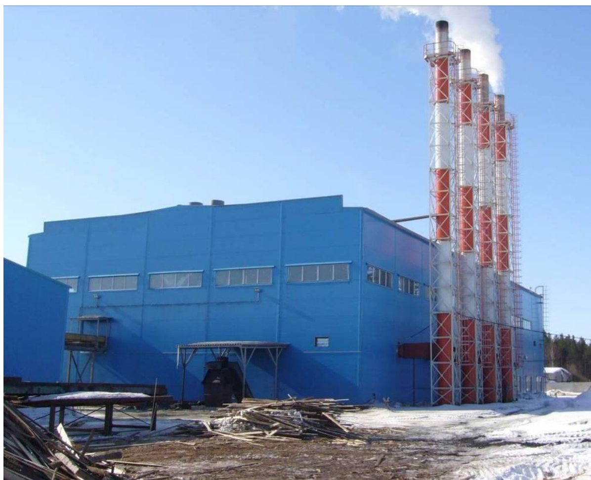
Рис. А.4-5. Новая котельная на биотопливе
