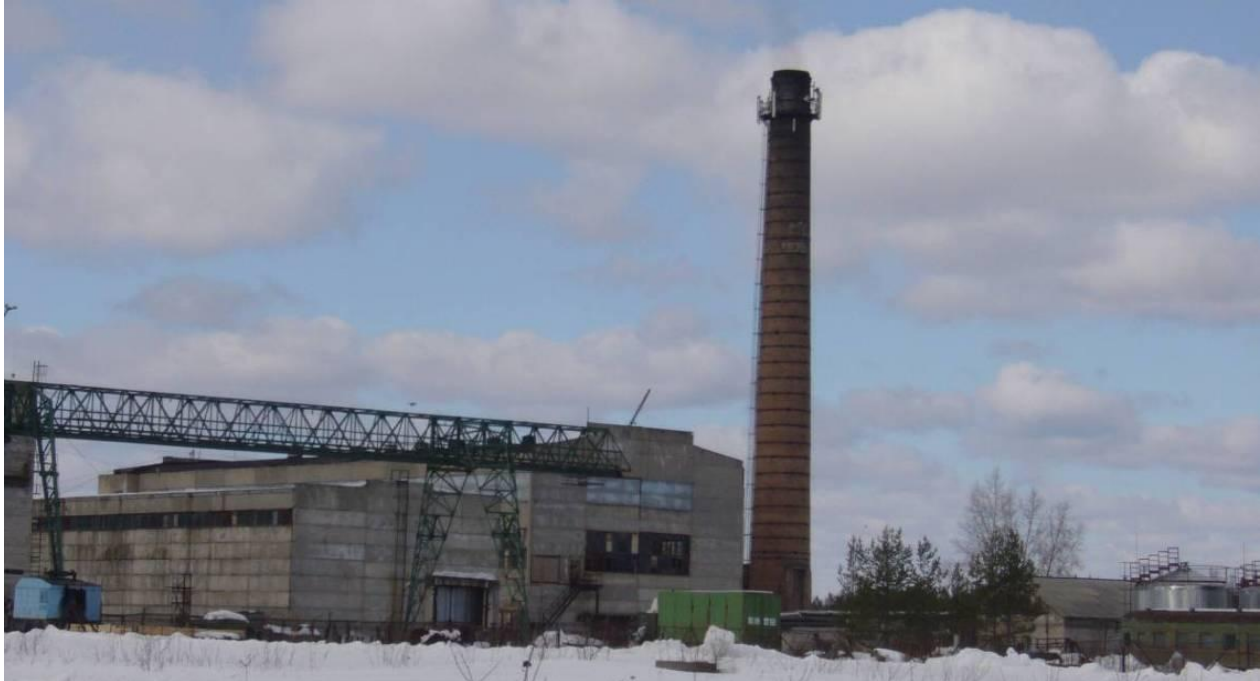
Рис. А.4-3. Мазутная котельная ОАО «СОБР»
